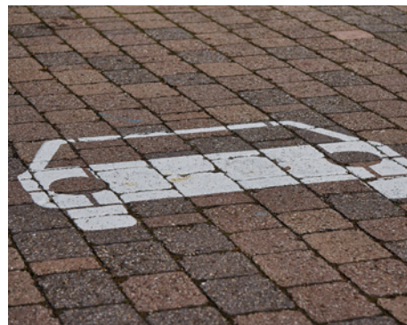
Sogenannte "Second Life"-Batterien stammen aus E-Autos und werden in Gebäuden, Solar- oder Windkraftanlagen verbaut. Bei den Speichersystemen besteht die Gefahr ein unkontrollierten Thermal-Runaway.
