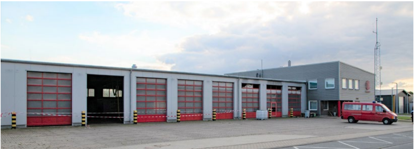
Die Brandschäden am Gerätehaus der FF Oldenburg sind immer noch deutlich sichtbar.
